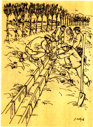
修筑防渗渠道
